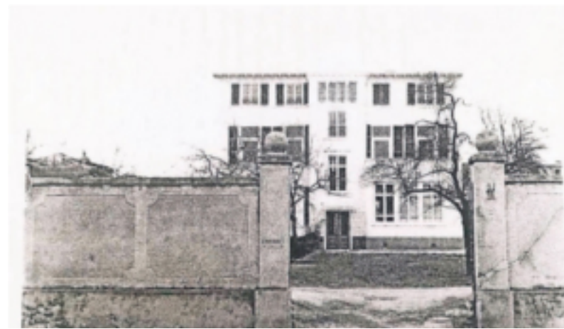
Ein Foto von anno dazumal zeigt, wie die Mauer vor der alten Landvilla einst ausgesehen hat.
