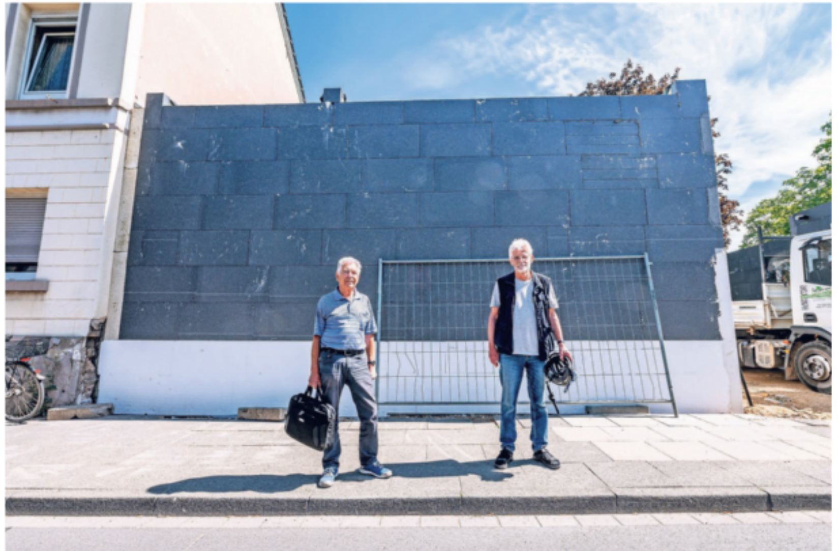
Kurioser Neubau: Henrich Fenner (links) und Thomas Falter vor einem der beiden Torhäuser mit der fensterlosen Fassade.
